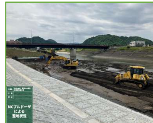
MCバックホウ・ブルドーザによる掘削・整地状況
