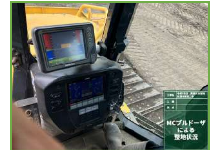
MCバックホウ・ブルドーザによる掘削・整地状況時の管理画面
