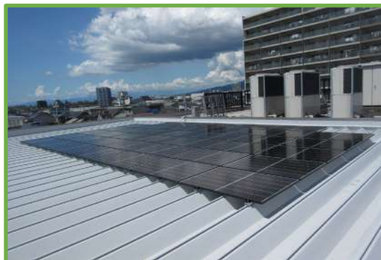
屋上に太陽光発電設備を設置 発電状況を見える化して発電量、売電量などを把握できるようにしています
